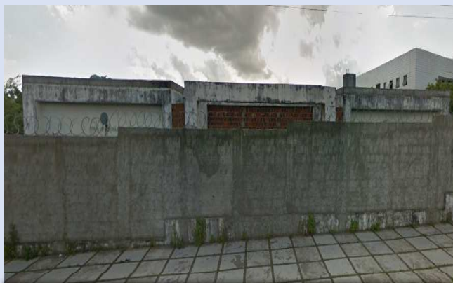
Nova Sede das Varas do Trabalho de Arapiraca.
